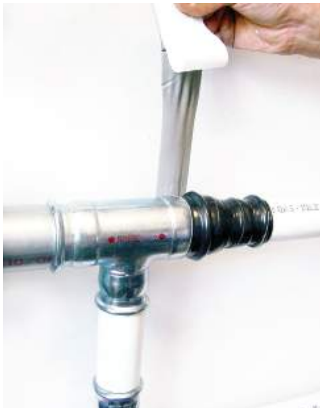
35.ábra - Kötésvédelem butanol ragasztószalaggal
