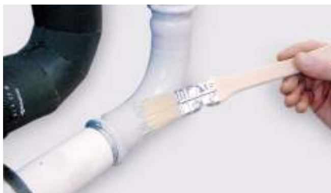
34.ábra - A csatlakozás és a cső festése alapozás után
