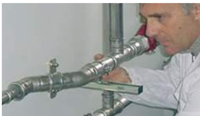
33.ábra - Sajtolts csőkötés ellenőrzése
