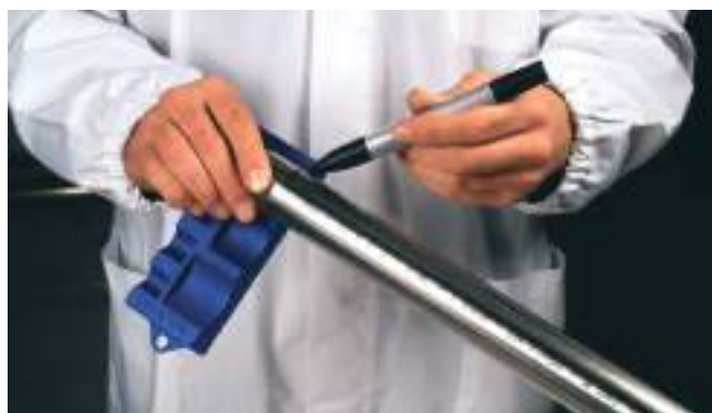
28.ábra - Beillesztési mélység jelölése.
