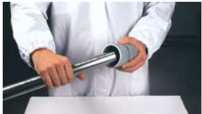
26.ábra - A csövek lesorjázása.
