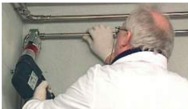
32.ábra - Préskötés kialakítása
